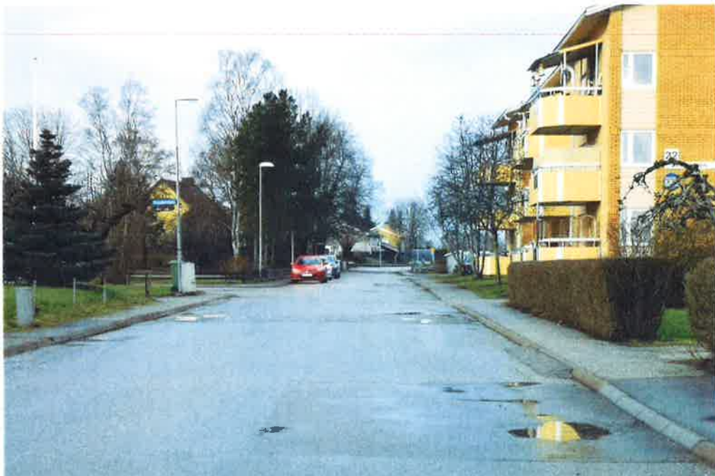
Bild 4. Infarter, vattensamlingar i körspår efter lätt regn.
