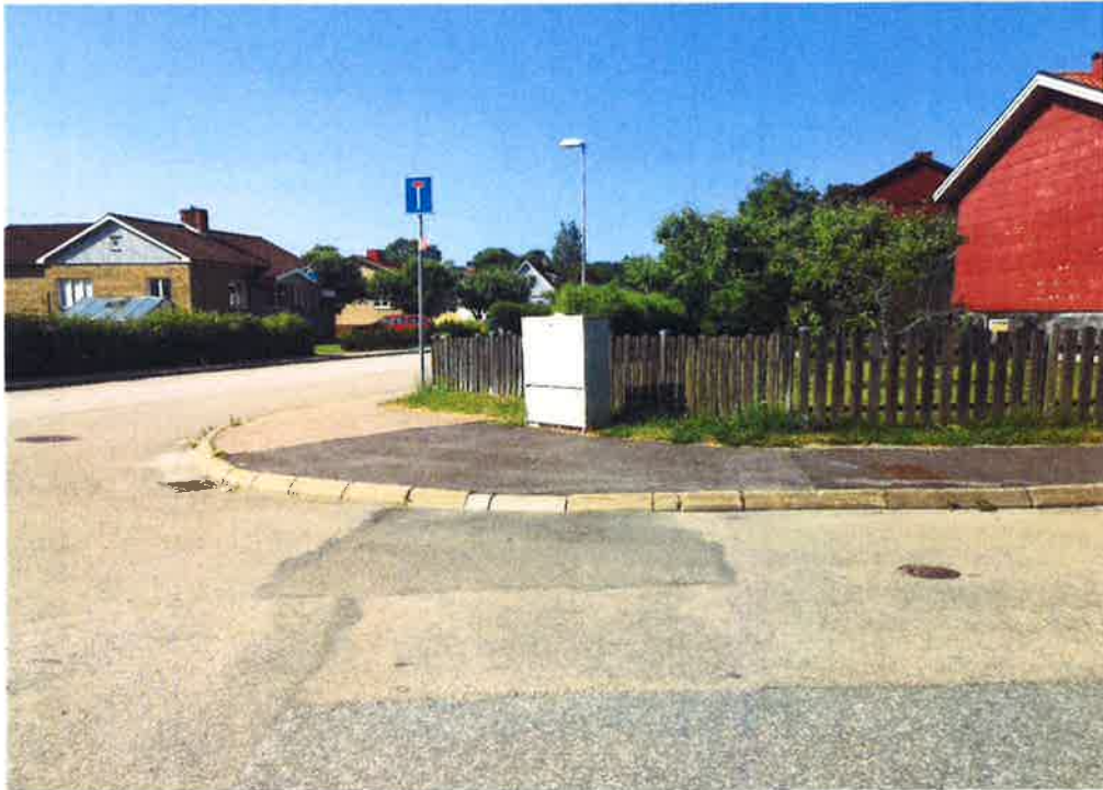
Bild 3. Variation, ett stort antal skarvar förekommer i beläggningen.
