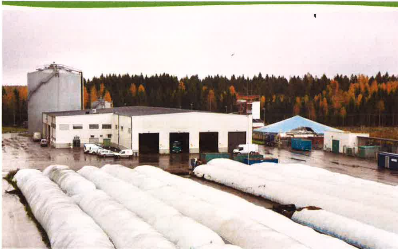
Biogasanläggningen på Gryta i Västerås byggs ut. Den förväntas vara klar i juli 2020 och kan då ta emot 40 000 ton biologiskt avfall per år för produktion av biogas och biogödsel.
