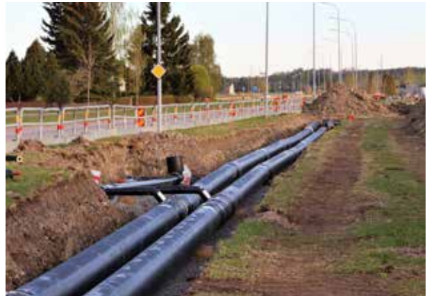
Ledningsdragning i full gång mellan Kolsva och Köping.
